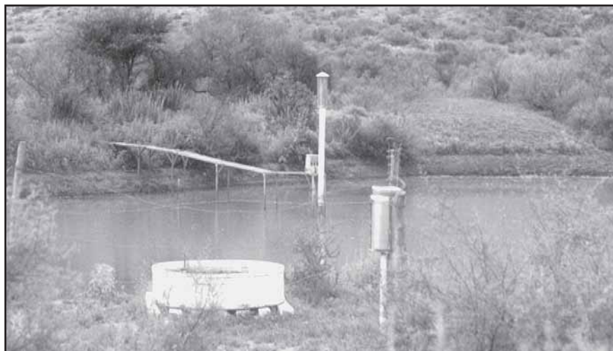
Figura 9. Equipo de medición instalado en cada uno de los bordos.
